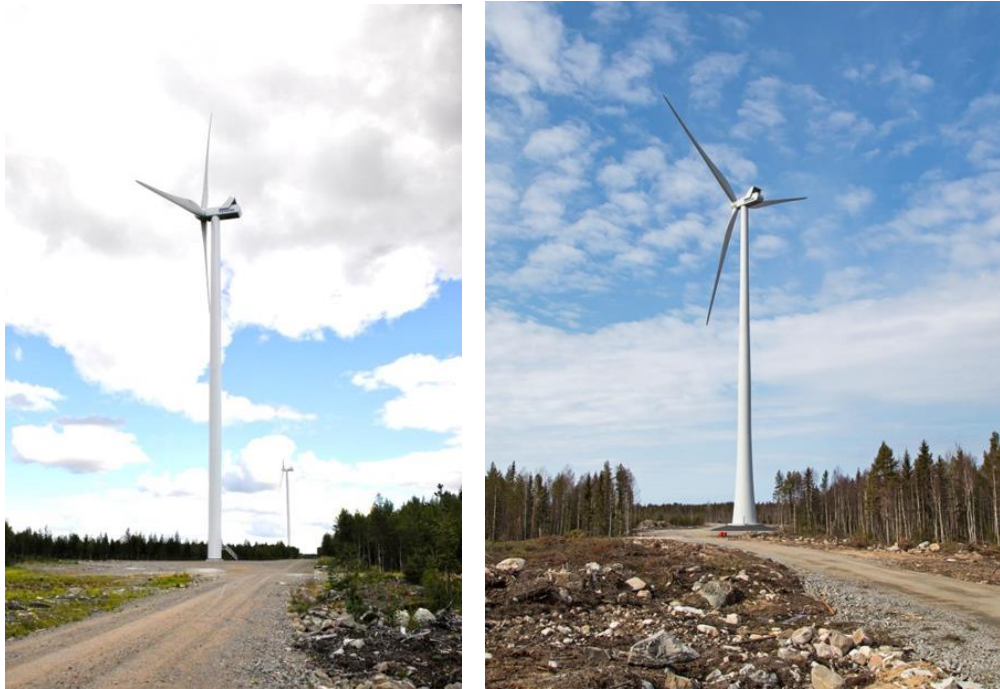
Bild 49. Till vänster ett exempel på ett cylindertorn och till höger ett hybridtorn. (Bilder: Leila Väyrynen och Ville Suorsa, FCG)
