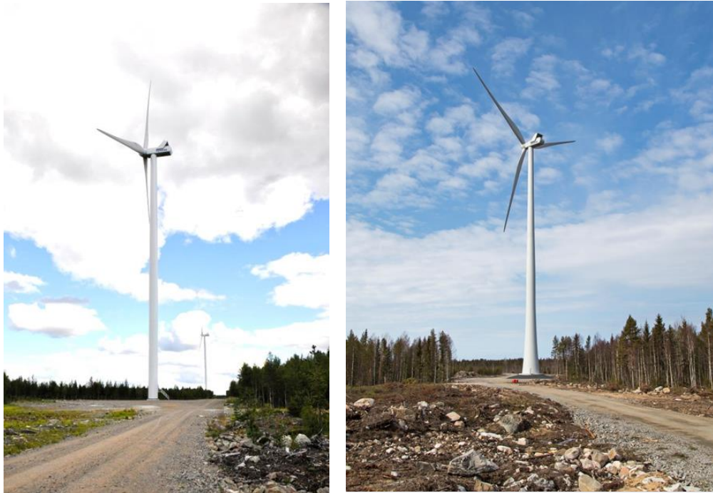
Kuva 49. Vasemmalla on esimerkki teräslieriötornista ja oikealla hybriditornista. (Kuvat: Leila Väyrynen ja Ville Suorsa, FCG)
