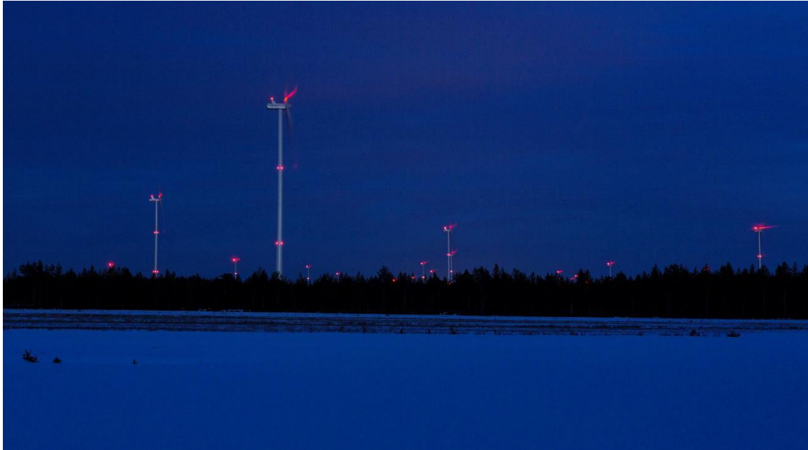
Kuva 51. Kiinteät punaiset lentoestevalot pimeällä. (Kuva: Ville Suorsa/FCG)
