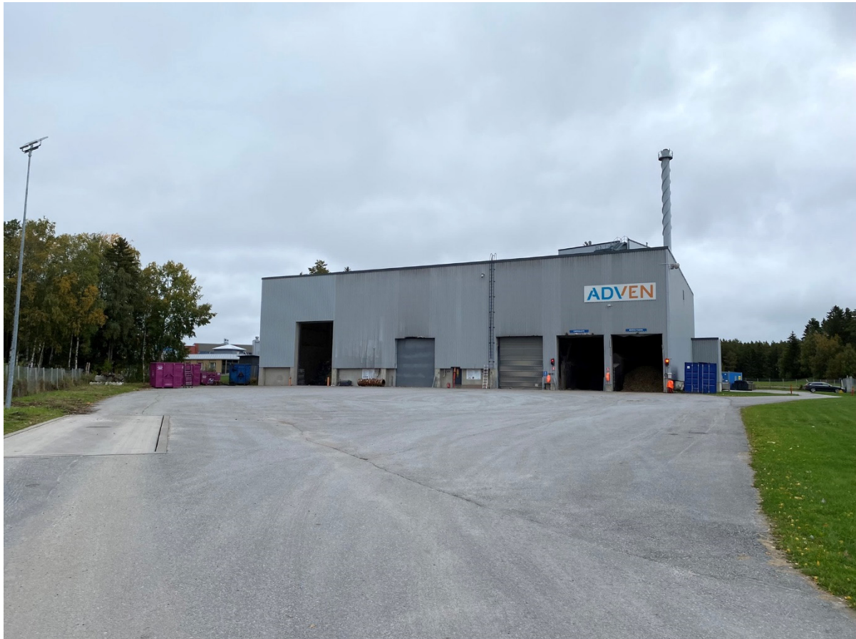
Kuva 12. Nykyinen lämpökeskus Kiitolantien (Kaavakartalla Hiomakuja) varressa.
