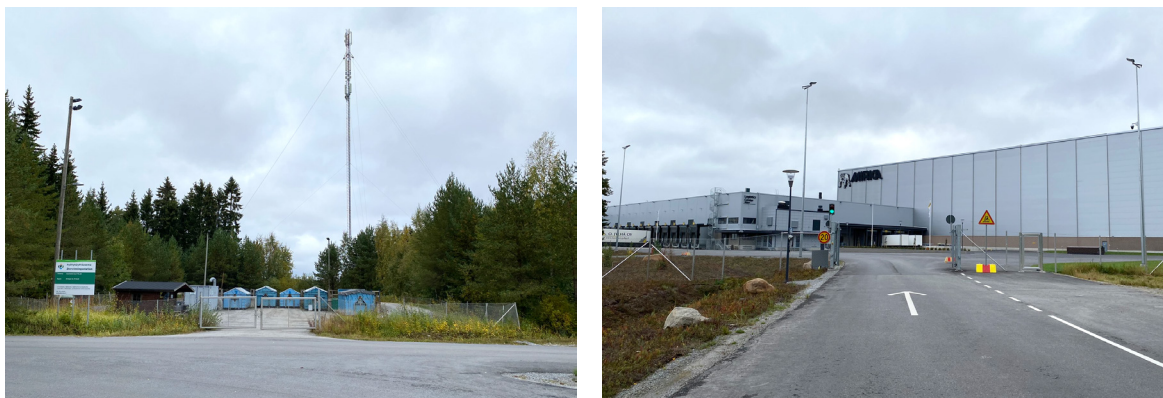
Bild 3. Till vänster; bild på ekopunkt och telemast belägna i områdets västra del. Till höger; inkörspport till Mirkas logistikcenter. Båge funktioner ansluter via samma gatuanslutning vid Pensalavägen 194.
